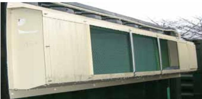
木枠の上に、エアマットカーテンを取付けます。水漏れ防止のため、右図のように、木枠縁より、約20mm下げて取付けて下さい。上部ガード部は、コーキングをして下さい。下部ガード部は、水抜きパッキンをつけて、ビス止めして下さい。
