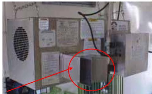
また、ヒーターの温風吹出し口には、必ず付属の「エアダイバター」を取付け、温風を左右に振る様にして下さい。(エアダイバターを取付けませんと、温風が直接水道配管等に当たり、トラブルを生じる場合がありますので、ご注意下さい。)
